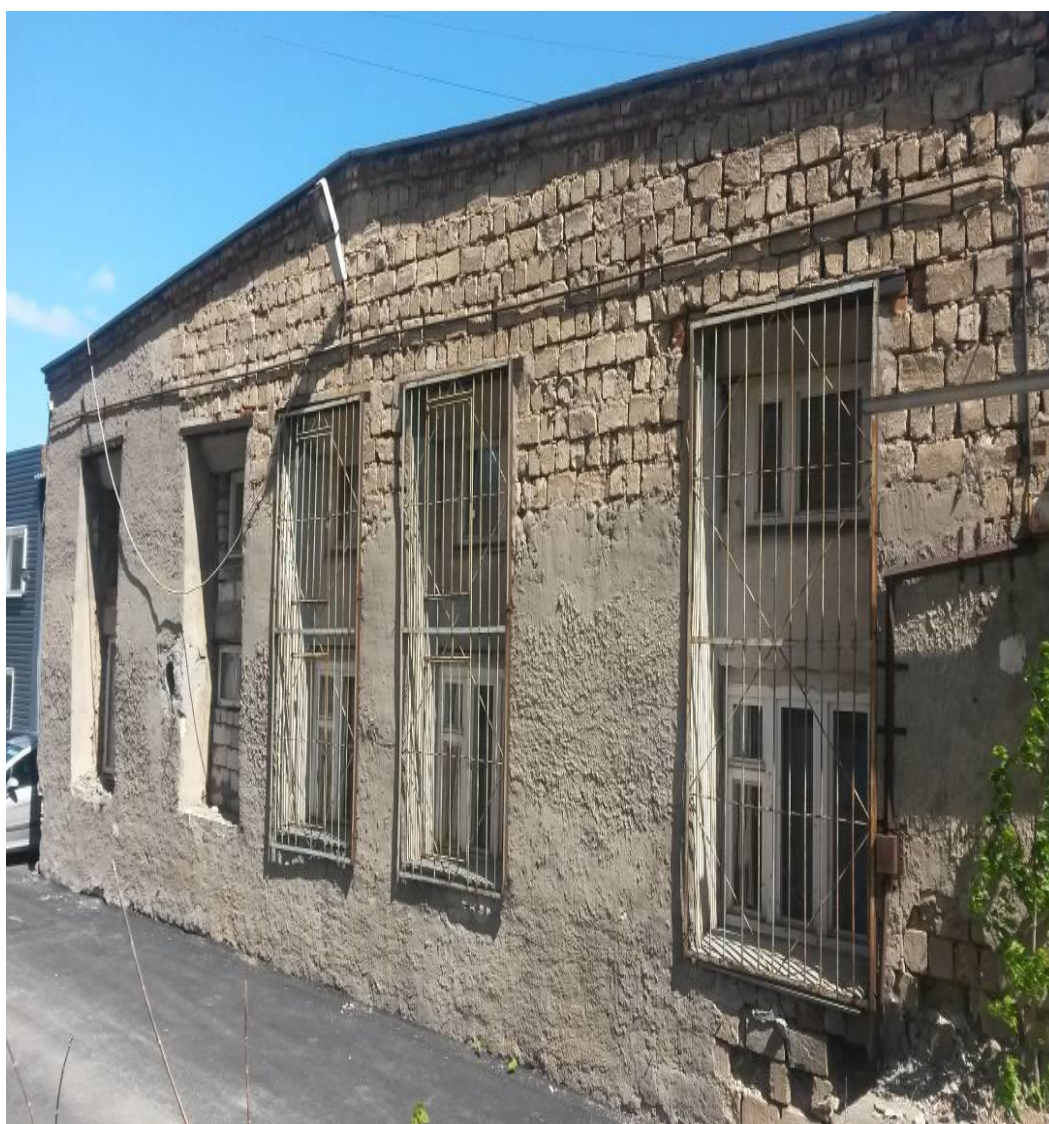
Рис.1. Дворовой фасад лабораторного корпуса строительного факультета ПНИПУ до ремонтных работ по устройству вентилируемого фасада. Здание построено 60-65 лет назад
